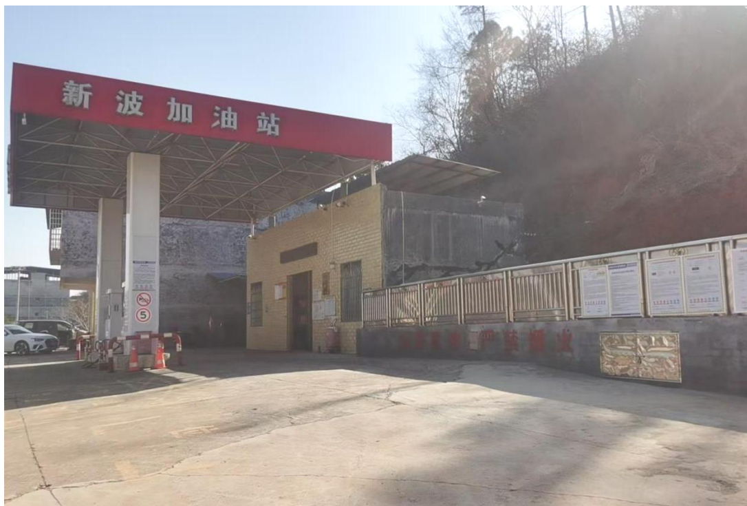
安仁县新波加油站现场勘察影像：（现场时间：2025 年 1 月 11 日）
